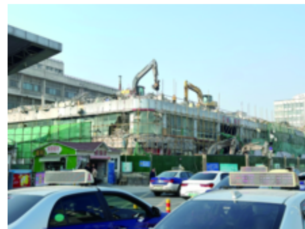
4月1日,天龙大厦拆除现场 记者 邹庆洋 付英杰 摄
