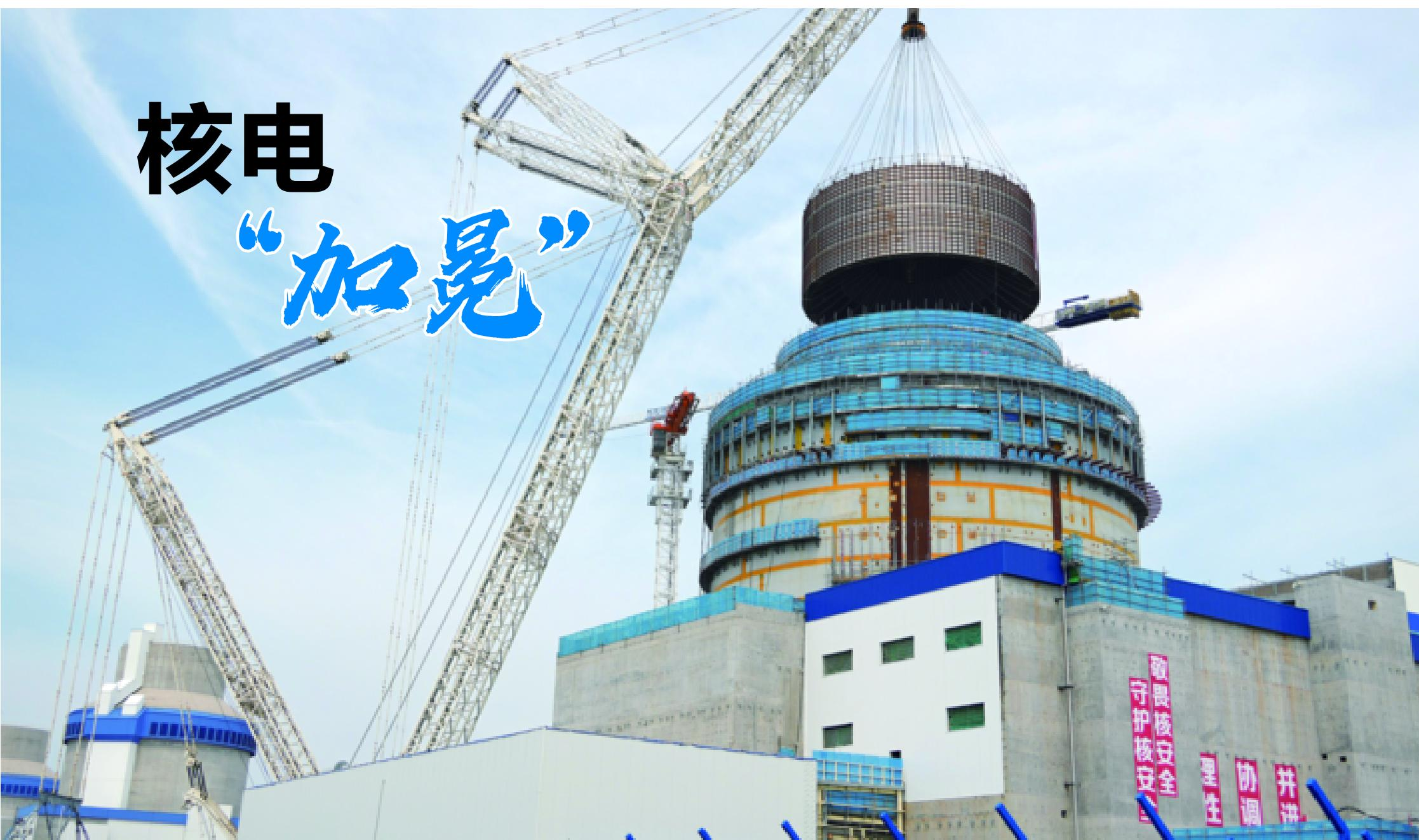
8月4日,国家电投山东海阳核电站3号机组核岛CB20模块顺利吊装就位,标志着该机组大型模块全部吊装完成,开始进入设备安装调试阶段。据了解,建设中的海阳核电3、4号机组是国家“十四五”规划重点项目,计划2027年全面投运。
