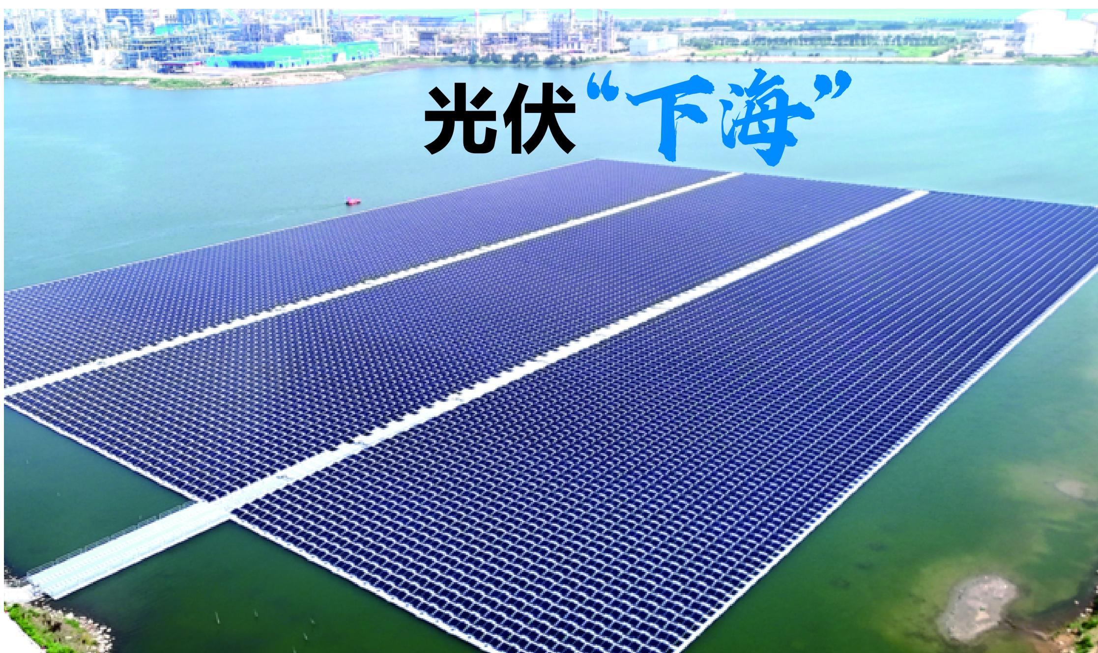
近日,国内首座工厂化全海水漂浮式光伏项目在中国石化青岛炼化公司并网发电。该项目位于青岛西海岸新区,装机容量7.5兆瓦,创新采用漂浮式结构,光伏板随潮汐升降贴近水面,利用海水高效散热提升发电效率。预计年发绿电近1000万千瓦时,减排二氧化碳0.83万吨,为沿海地区推广提供了重要示范。图为7月4日拍摄的中国石化青岛炼化全海水环境漂浮式光伏项目现场。
