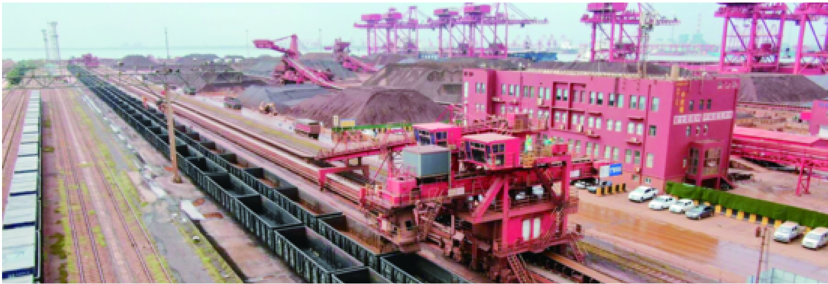
日照港拥有多个 30 万吨级铁矿石接卸码头 受访者供图
